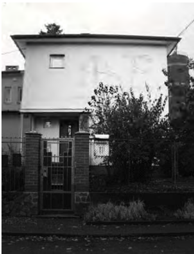
Рис. 7. Будинок на вул. Кибальчича, 11: а – загальний вигляд; Б б – графічне зображення модифікованого сграфіто – різьба по тиньку
