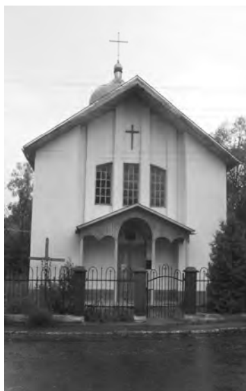
Фото 6. Церква Св. Арх. Михаїла у смт Бориня
