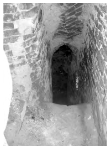
Рис. 10. Збережений фрагмент сходів всередині притвору костелу Домініканців
